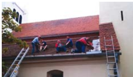
Oprava strechy na kostole čítajte na str. 6
